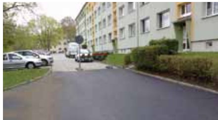
Straße des Bergmanns 45 a – e
