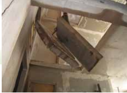
Aufschneiden der Decken
