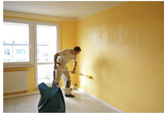
Bei der Vorbereitung zur Vermietung werden bei Malerarbeiten Wünsche neuer Mieter berücksichtigt.
