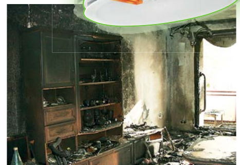
Ein Rauchwarnmelder hätte die Schäden dieses Brandes vielleicht mindern können.
