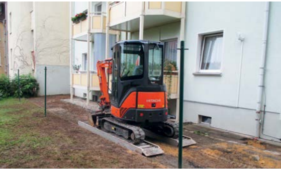
Eine defekte Entwässerungsleitung in der Laasener Straße sorgte für aufwändige Arbeiten im Wohnumfeld.
