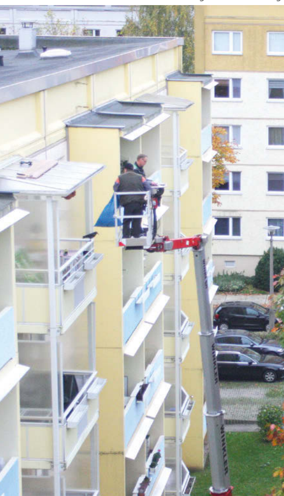
Nach Hagelschäden waren Balkondachenerneuerungen in der Saalfelder Straße, der Walter-Gerber-Straße und der Straße des Bergmanns notwendig.
