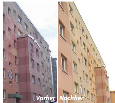
In der Zeulsdorfer Straße 1–11 wurden Algenbeläge von der Fassade entfernt.
