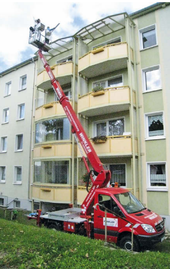
Nach Hagelschäden waren Balkondachenerneuerungen in der Saalfelder Straße, der Walter-Gerber-Straße und der Straße des Bergmanns notwendig.
