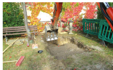
Der Trinkwasseranschluss in der A.-S.-Makarenko-Straße 73–77 wurde erneuert.
