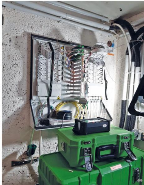
Der Ausbau des Glasfasernetzes ist in fast allen Objekten fertiggestellt – die Saalfelder Straße und die Zeulenroder Straße stehen noch aus. Die Leitungen sind bis in die Keller verteilt und die Steigleitungen inkl. Anschlussdose bis in die Wohnungen hergestellt. Die gelegten Leitungen werden im kommenden Jahr inbetrieb genommen und versorgen dann die ersten Nutzer mit Glasfaser-Highspeed.
