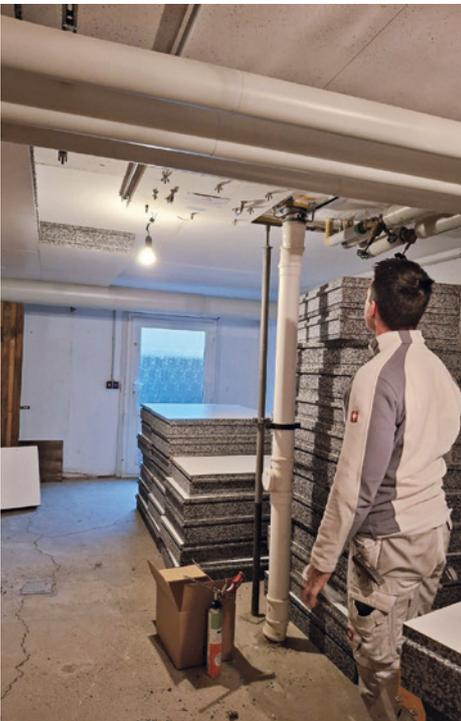
Die Heizventile und die Kellerdecken-dämmung wurden in der Steinbeckstraße 31 a – d gewechselt. Zudem wurde eine Drepeldämmung eingebracht und die Rohrleitungen im Drepel gedämmt. Diese Maßnahme verbessern die energetischen Einsparungen des Hauses weiter.
