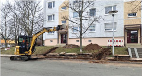
Im Frühjahr begannen die vorbereitenden Arbeiten der Strangsanierung, bei denen u. a. die Hausanschlüsse ausgewechselt wurden.
