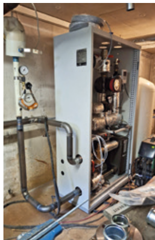
Zeulsdorfer 63 – 73 Eine neue Hausanschlussstation wurde im August eingebaut.
